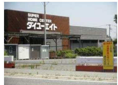
閉鎖された店舗と 「帰還困難区域」の看板
